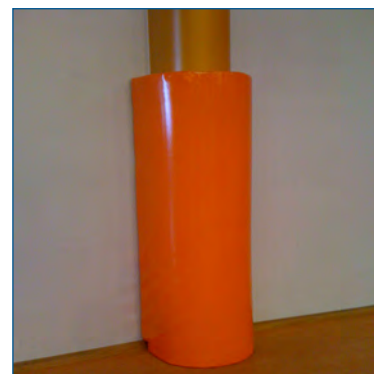
Poteau lamellé-collé à ceinturer.
