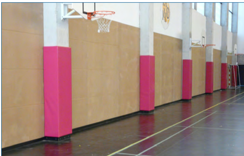
Réf. 60 020 Sur poteau béton.
